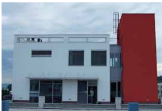
Novi prostori reševalne postaje Izola
